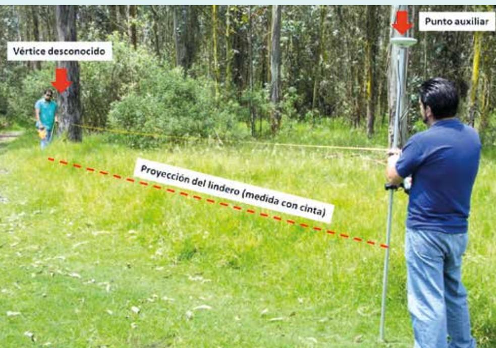
Figura 19: Vértice determinado mediante un punto auxiliar alineado al lindero
